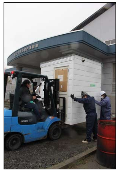
並排安放在室內運動場入口
