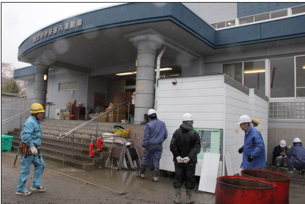
打開浴室的連接口，準備給水、排水和熱水爐的安裝工程。
