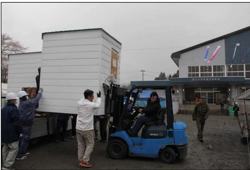
流動浴室從貨車運來後，利用鏟車進行近距離搬運
